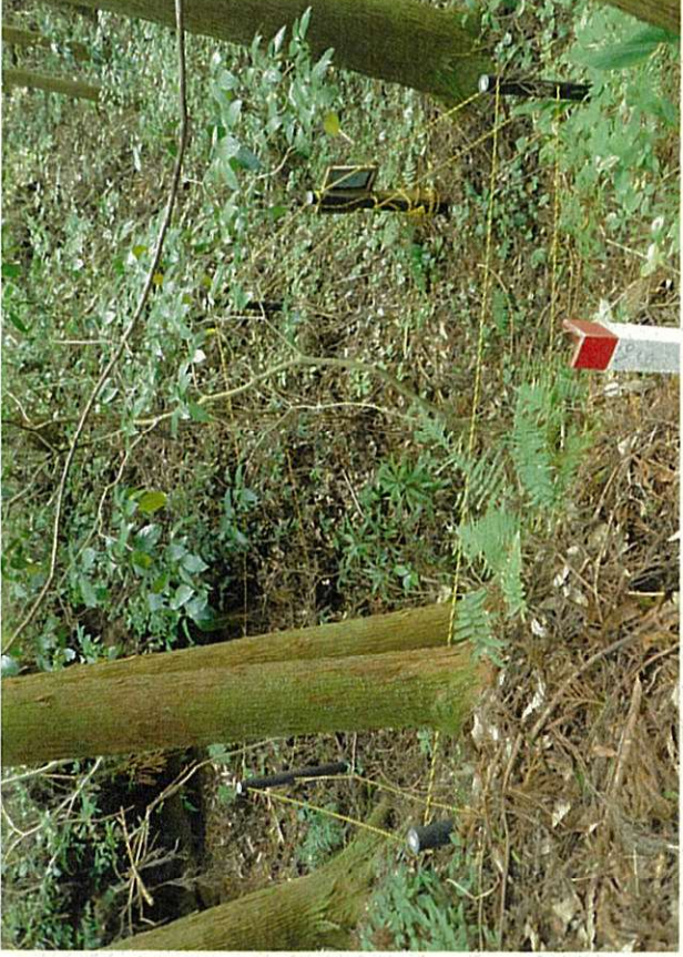
令和2年10月16日撮影 定期点検
